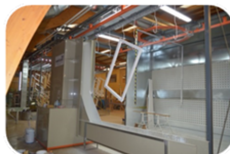
Flutanlage und Endlackierung mit Drehung der Traversen
